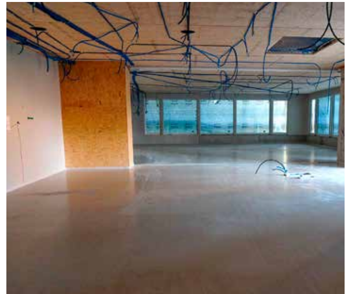
Unterlagsboden im Speisesaal
