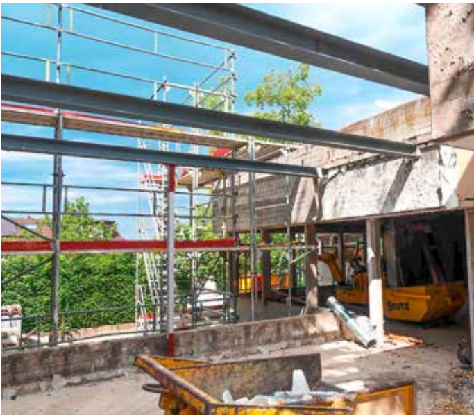
Anbau der Stahlträger
