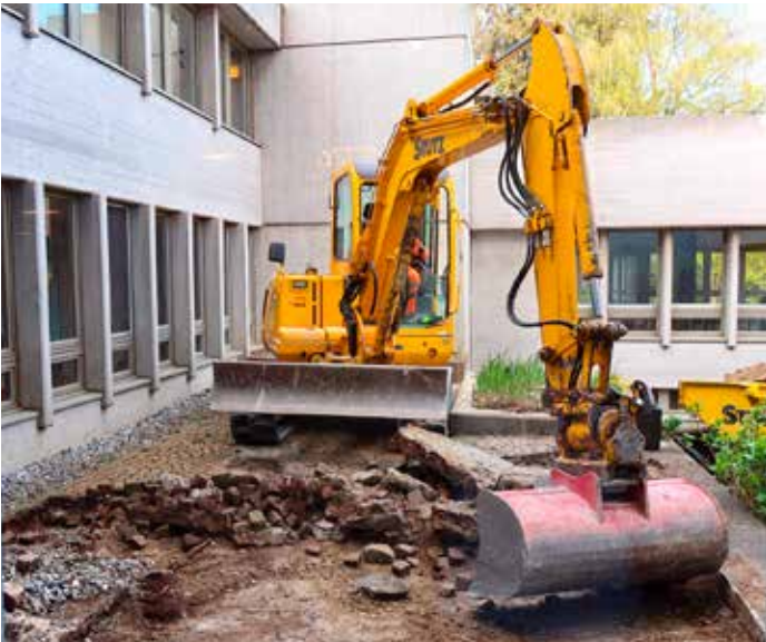
Bagger im Atrium
